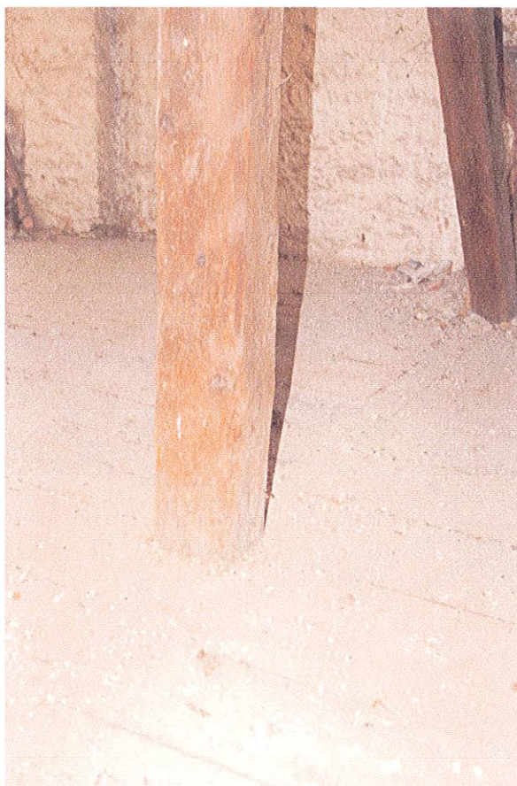
- Zdjęcie nr 5 : Podstawa słupa do wzmocnienia.
