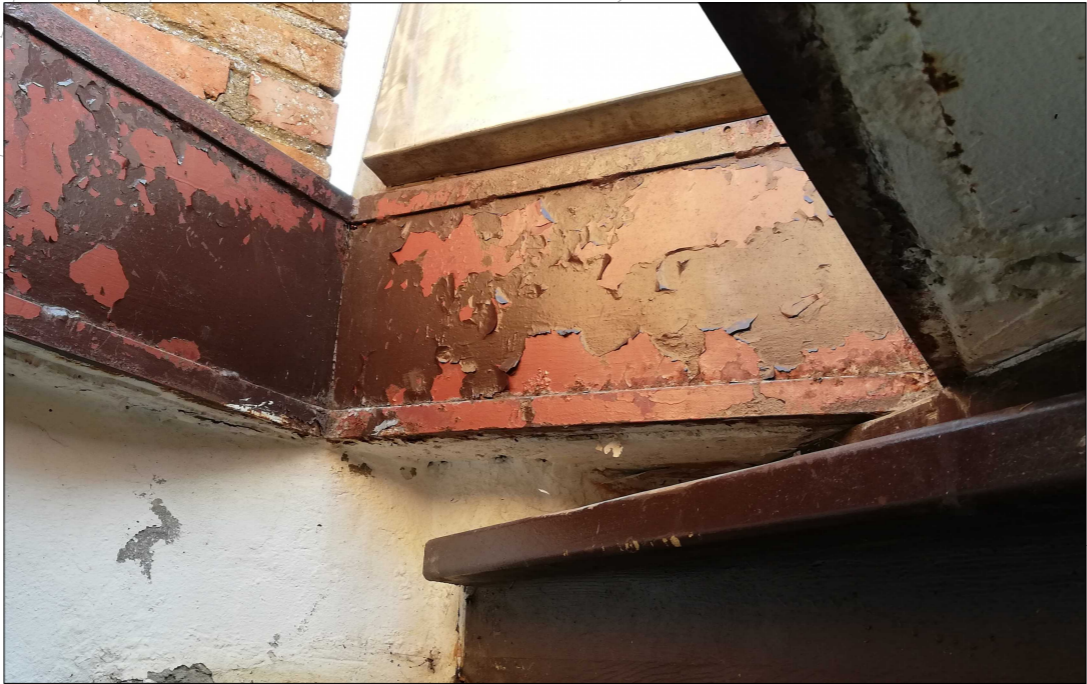
stalowe elementy wykończenia otworu klapy - należy zdjąć stare powłoki farby, zabezpieczyć antykorozyjnie, pomalować w kolorze ciemnobrązowym. otwór w świetle przełazu 80x60cm. należy do istniejącego otworu dopasować wyłaz dachowy ze świetlikiem, z siłownikiem (D4)
