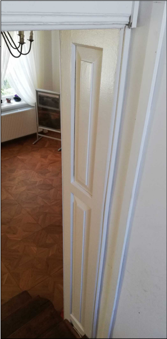
elementy drewniane malowane przeznaczone są do renowacji - zgodnie z częścią opisową dotyczącą elementów stolarki drzwiowej
