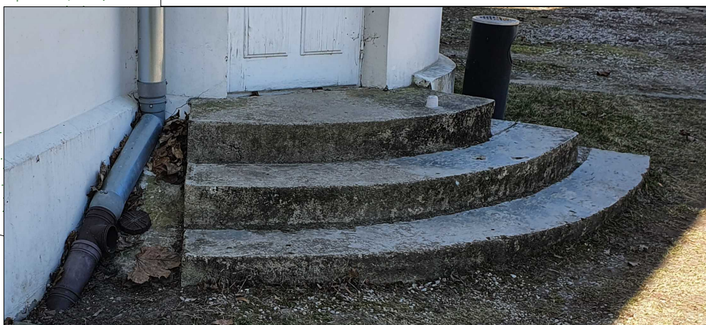
schody istniejące należy oczyścić, wyrównać, założyć izolację przeciwwodną w płynie. okładzina schodów z impregnowanego kamienia piaszczowca w kolorze beżowym. stopnice z zaokrąglonymi noskami
