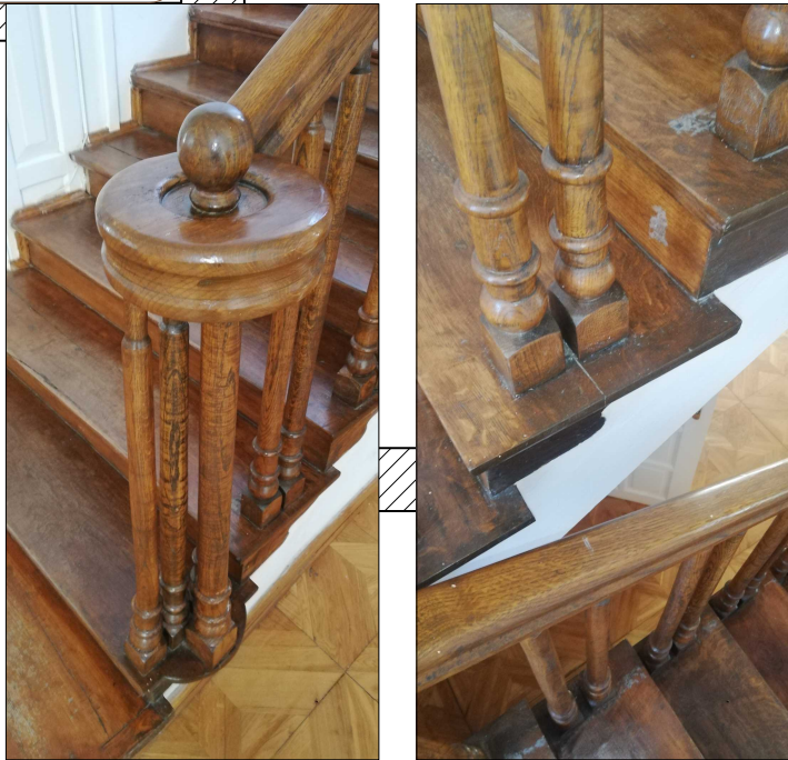
balustrada istniejąca do renowacji zgodnie z częścią opisową. mocowanie balustrady należy wzmocnić - doprowadzić do stabilności elementu.
