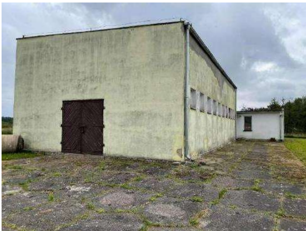
Rysunek 59. Zdjęcie budynku stacji uzdatniania wody w Przebędowie.
