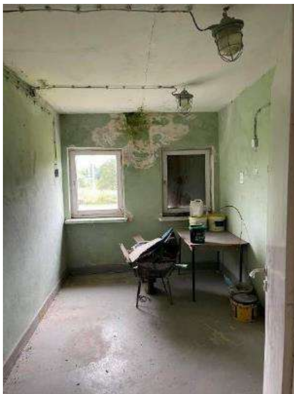
Rysunek 71. Zdjęcie pomieszczeń do remontu wewnątrz w budynku stacji uzdatniania wody w Przebędowie.
