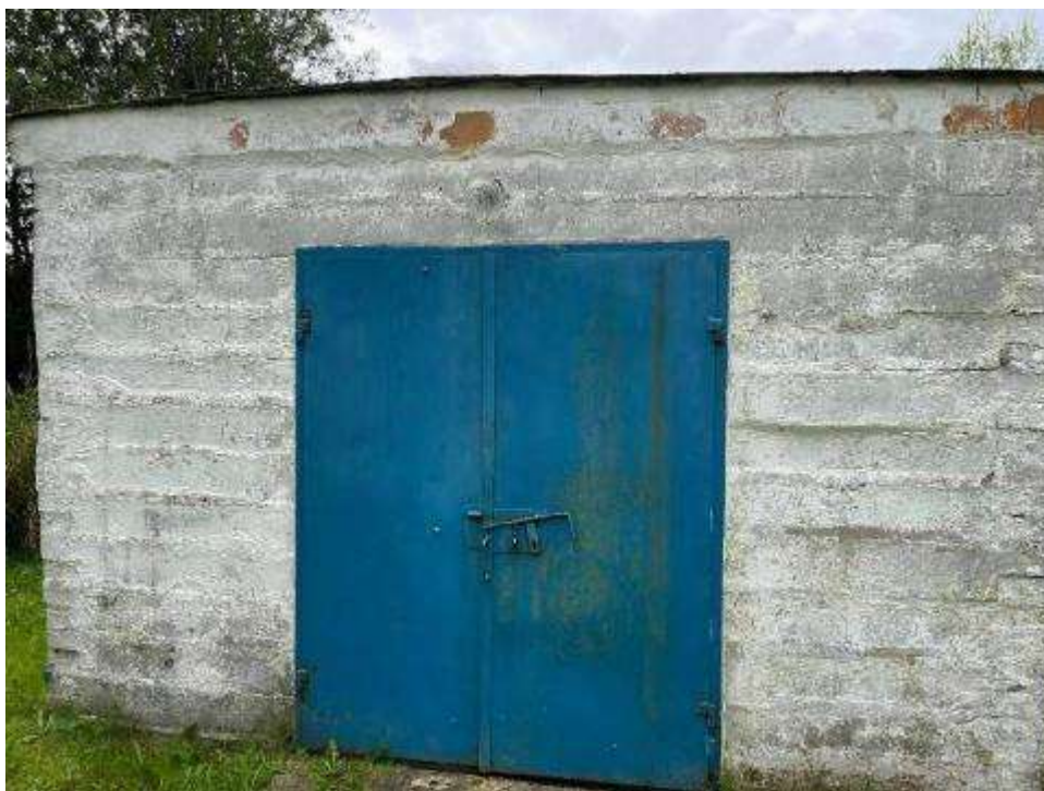
Rysunek 3. Zdjęcie- Budynek stacji uzdatniania wody wraz z drzwiami przewidzianymi do wymiany.
