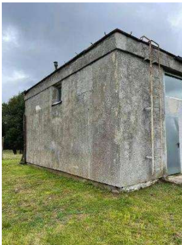
Rysunek 32. Zdjęcie budynku stacji podnoszenia ciśnienia w Lelkowie.
