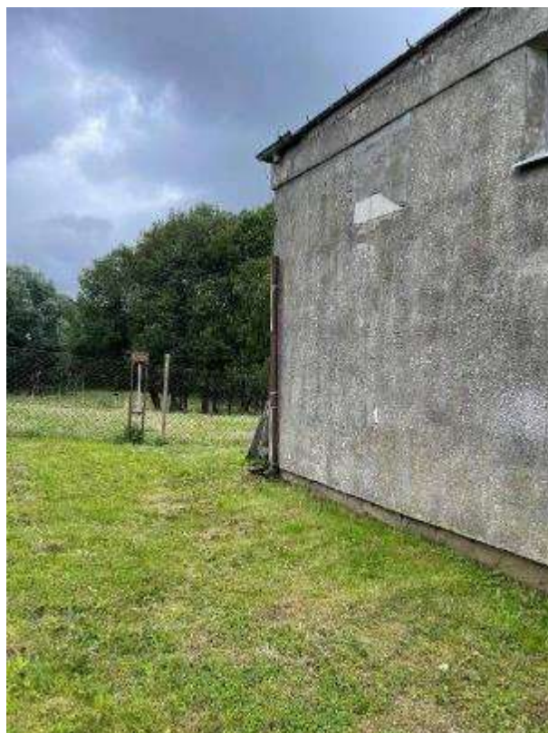
Rysunek 33. Zdjęcie budynku stacji podnoszenia ciśnienia w Lelkowie.
