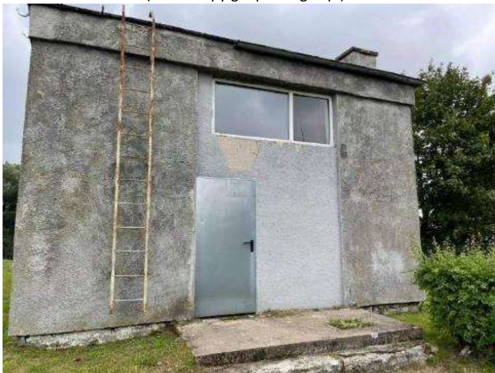
Rysunek 30. Zdjęcie budynku stacji podnoszenia ciśnienia w Lelkowie.
