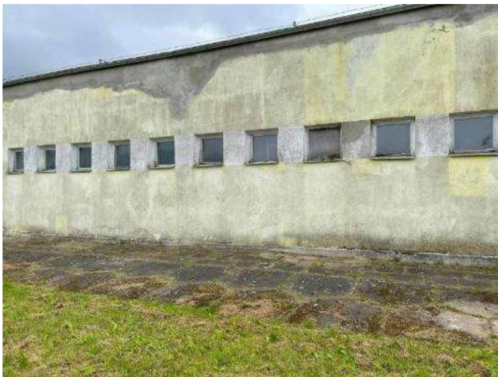
Rysunek 55. Zdjęcie budynku stacji uzdatniania wody w Przebędowie.
