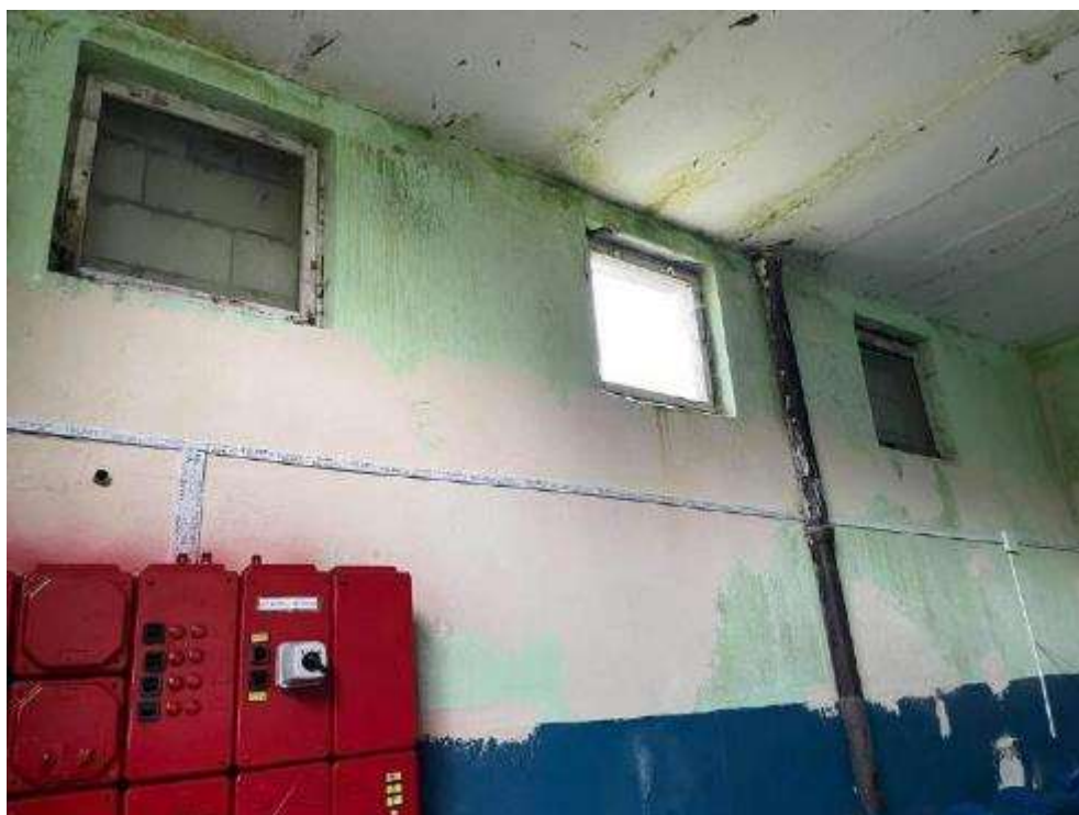
Rysunek 34. Zdjęcie wewnątrz budynku stacji podnoszenia ciśnienia w Lelkowie (środkowe okno do wymiany).
