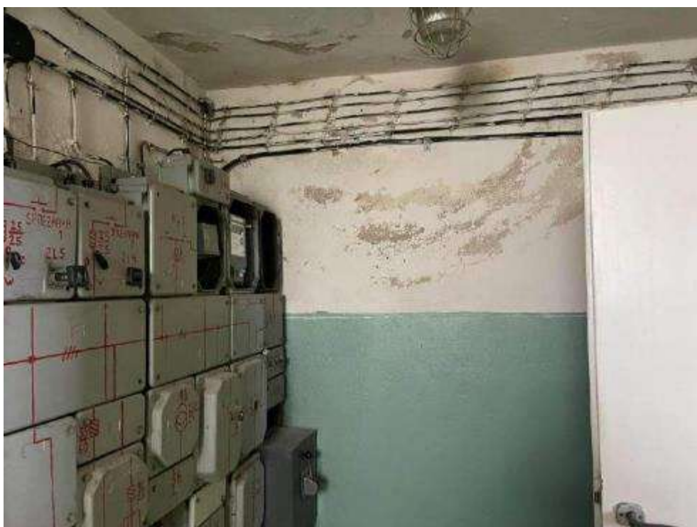
Rysunek 76. Zdjęcie pomieszczeń do remontu wewnątrz w budynku stacji uzdatniania wody w Przebędowie.
