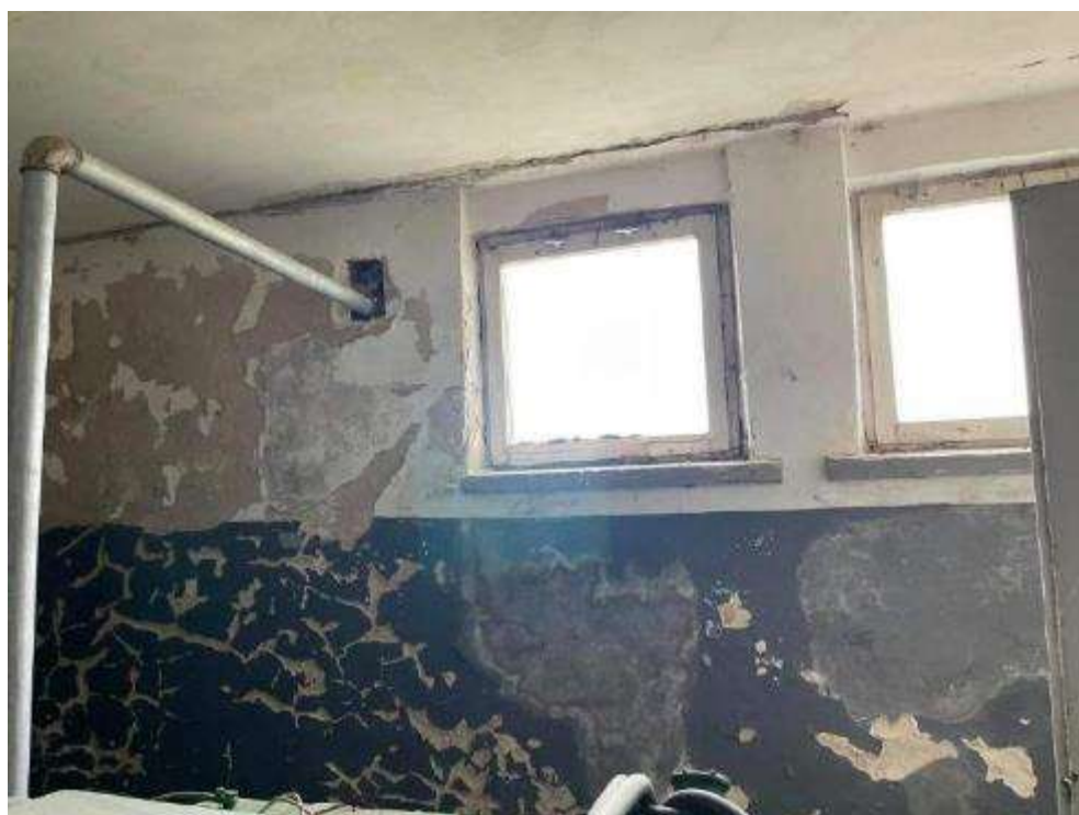
Rysunek 72. Zdjęcie pomieszczeń do remontu wewnątrz w budynku stacji uzdatniania wody w Przebędowie.
