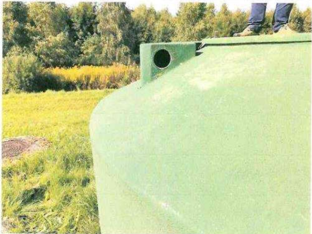
Złoże II stopnia z wypełnieniem PESZEL
