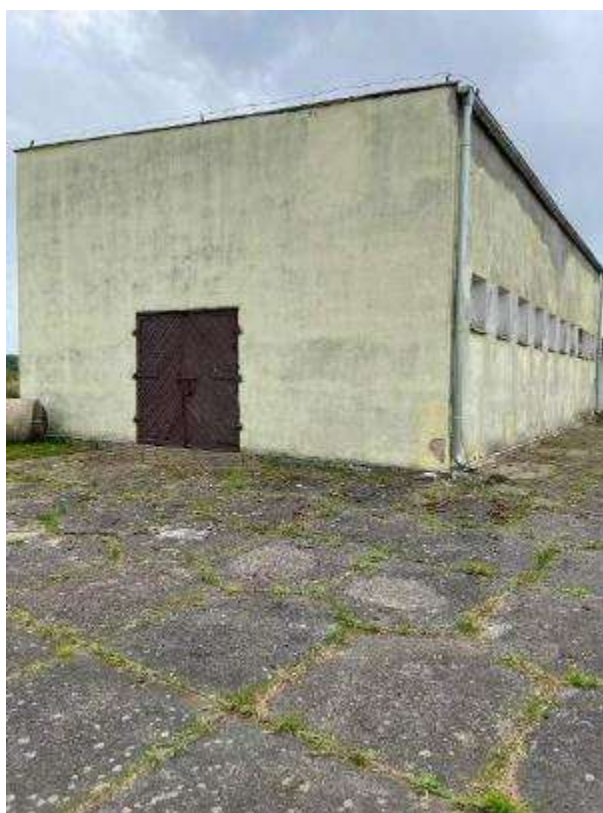
Rysunek 54. Zdjęcie budynku stacji uzdatniania wody w Przebędowie.
