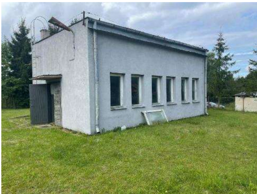
Rysunek 50. Zdjęcie budynku stacji uzdatniania wody w Głębocku.
