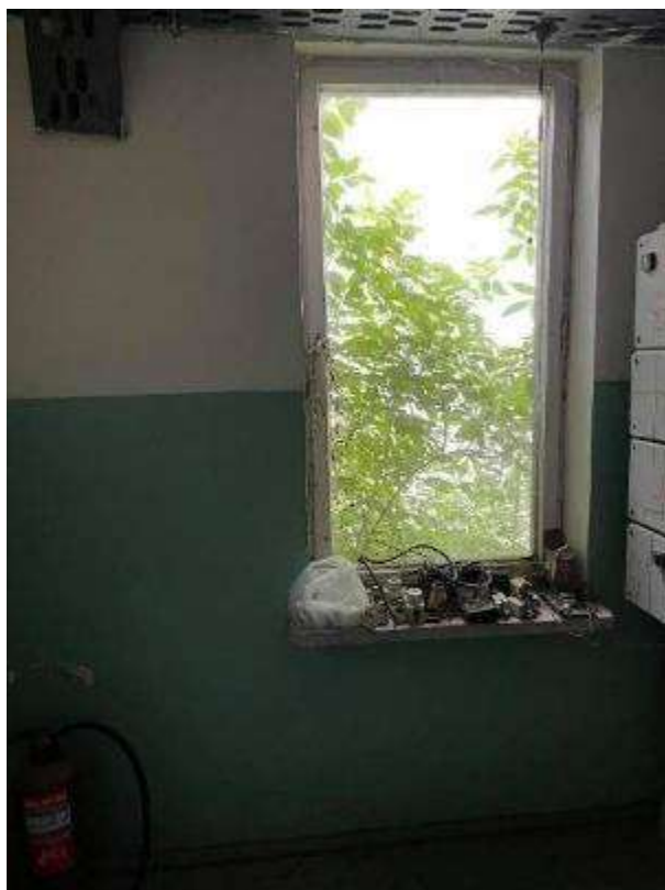
Rysunek 77. Zdjęcie pomieszczeń do remontu wewnątrz w budynku stacji uzdatniania wody w Przebędowie.
