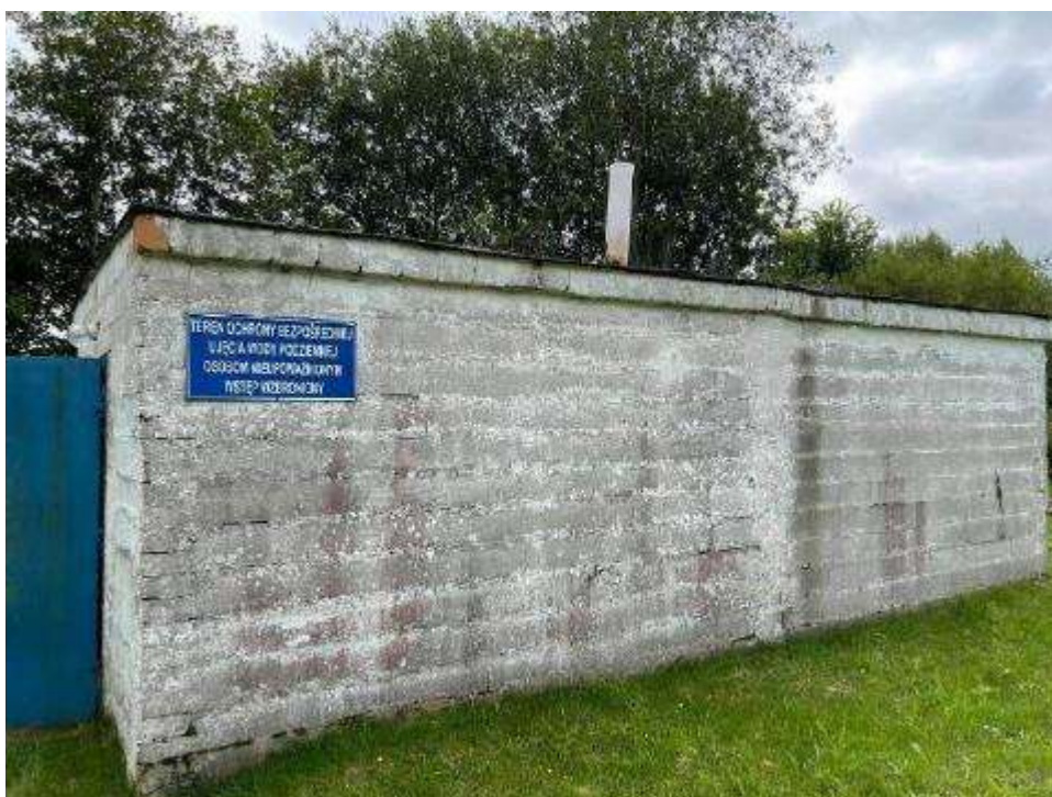
Rysunek 4. Zdjęcie- Budynek stacji uzdatniania wody do termomodernizacji.
