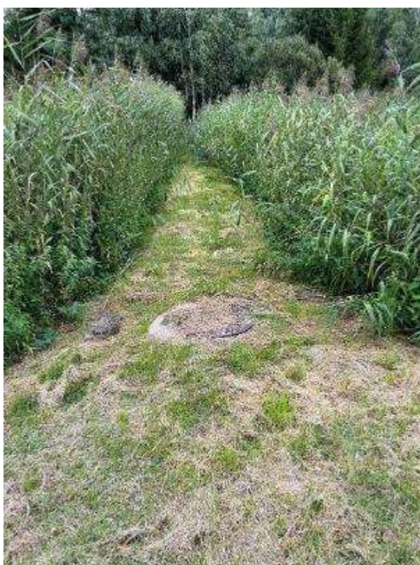
Rysunek 28. Zdjęcie studni rozdzielczej i poletek trzcinowych na oczyszczalni ścieków w Lelkowie.
