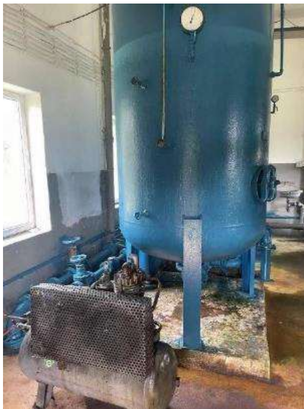
Rysunek 51. Zdjęcie budynku wewnątrz stacji uzdatniania wody w Głębocku.
