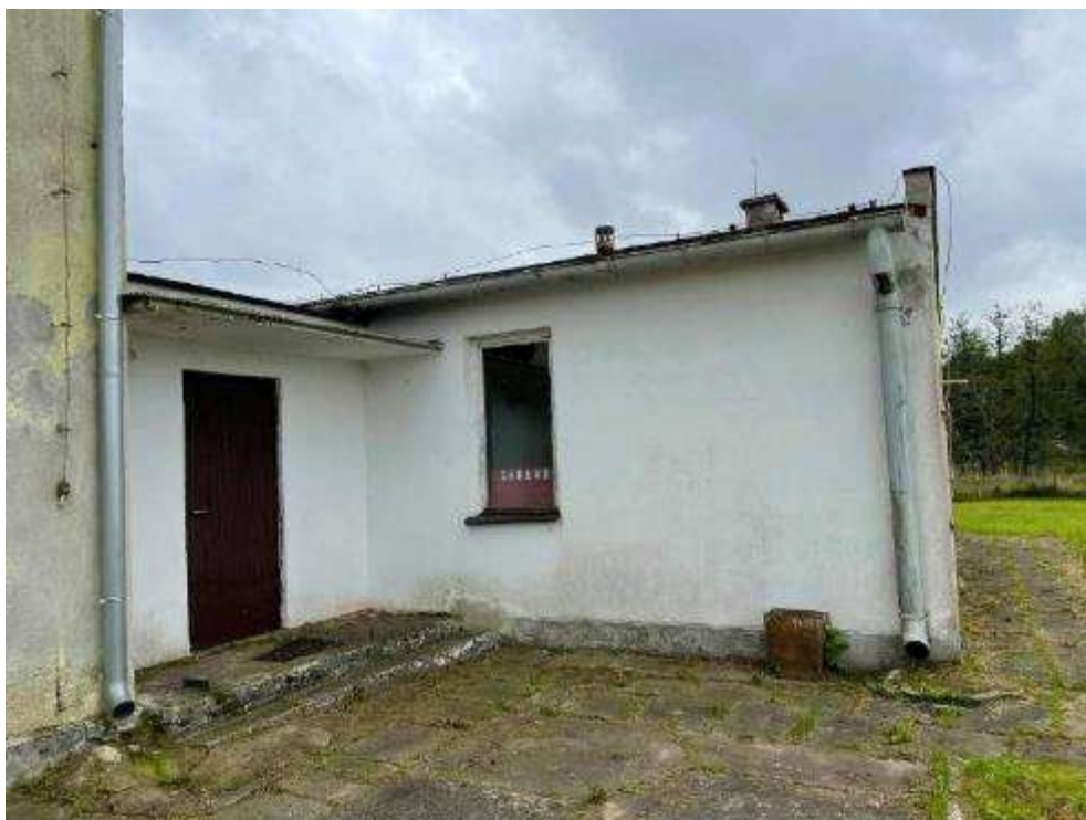
Rysunek 60. Zdjęcie budynku stacji uzdatniania wody w Przebędowie.
