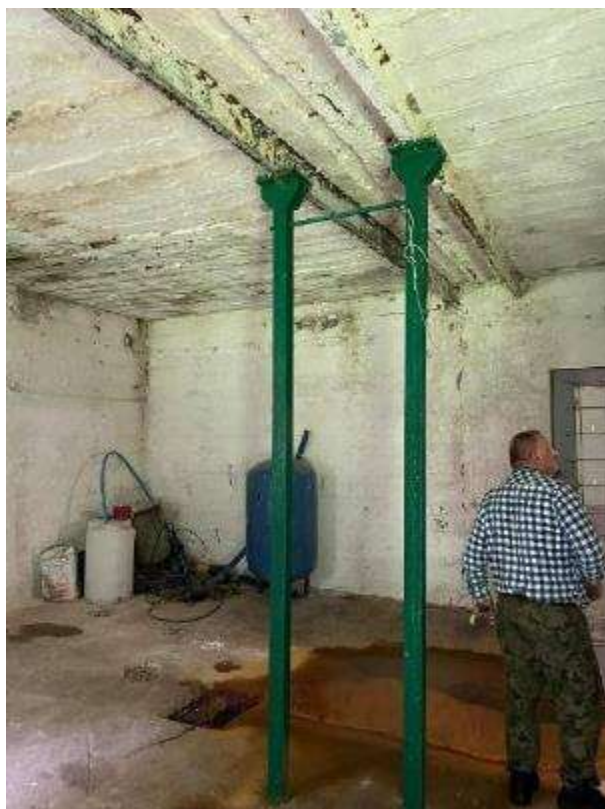
Rysunek 44. Zdjęcie budynku stacji uzdatniania wody w Jachowie wewnątrz (część, nieużytkowana wraz ze wskazaniem ewentualnego miejsca, gdzie można by zmniejszyć powierzchnię budynku).
