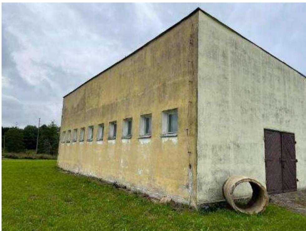
Rysunek 58. Zdjęcie budynku stacji uzdatniania wody w Przebędowie.
