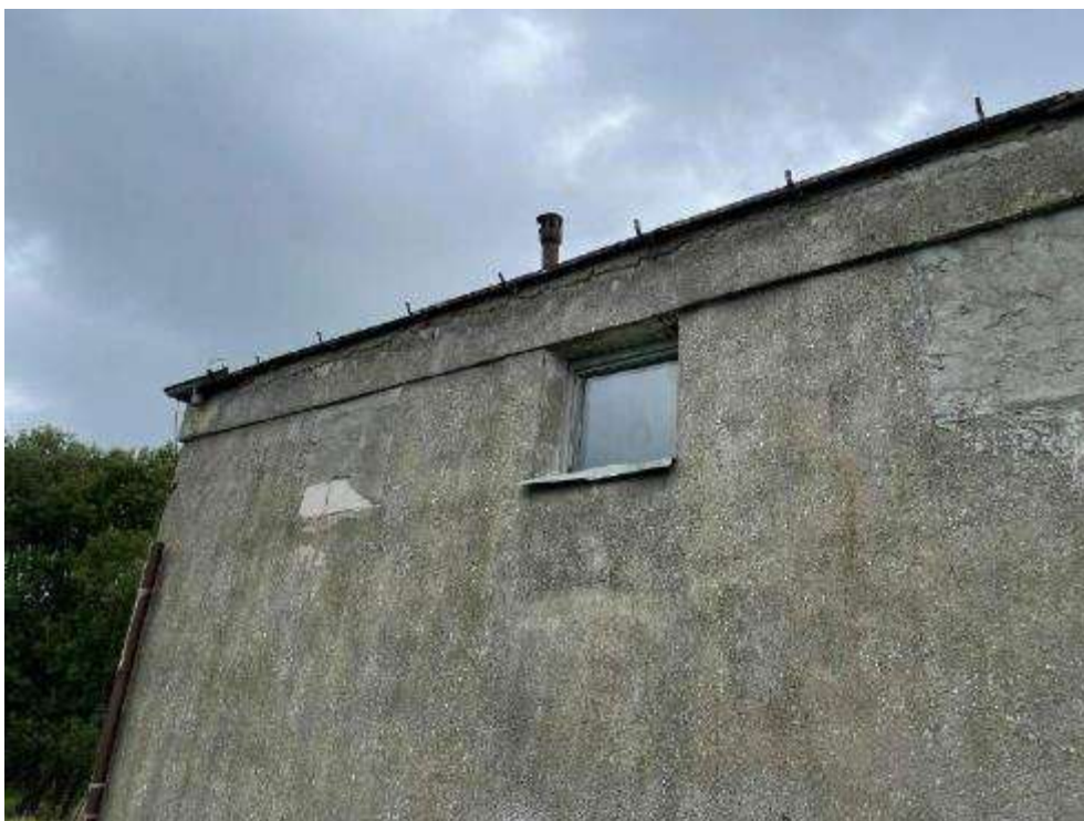
Rysunek 31. Zdjęcie budynku stacji podnoszenia ciśnienia w Lelkowie.
