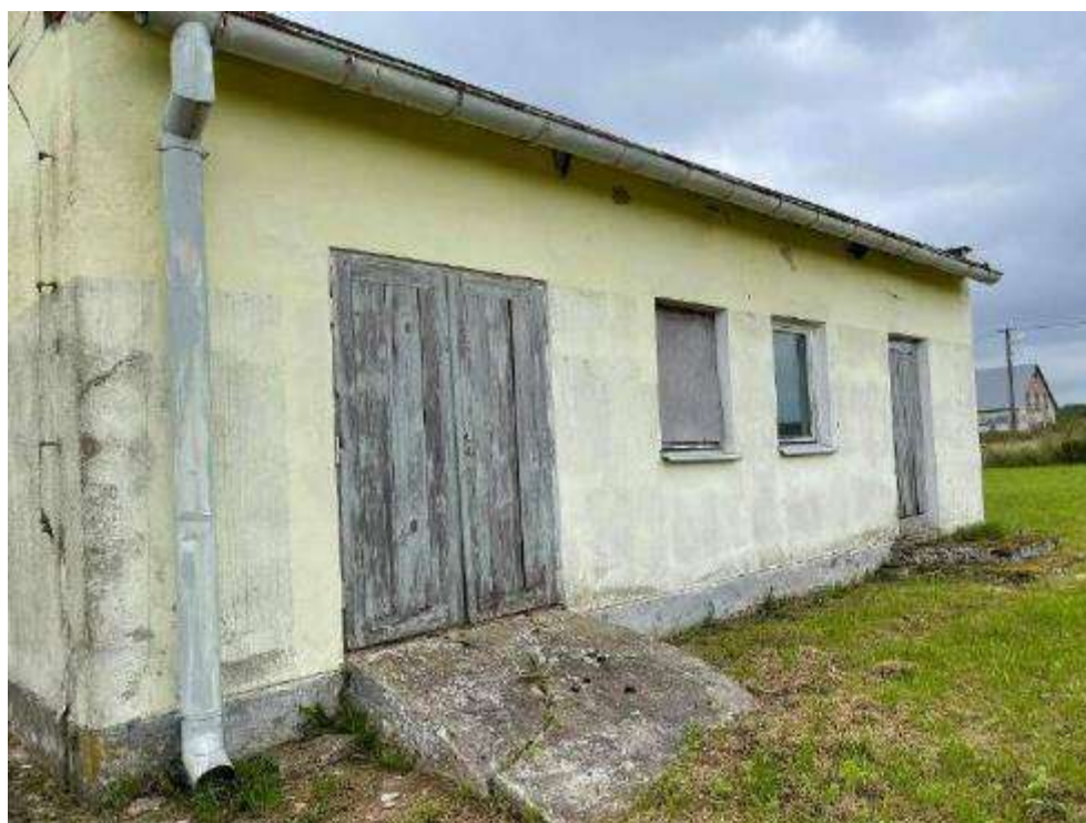
Rysunek 56. Zdjęcie budynku stacji uzdatniania wody w Przebędowie.
