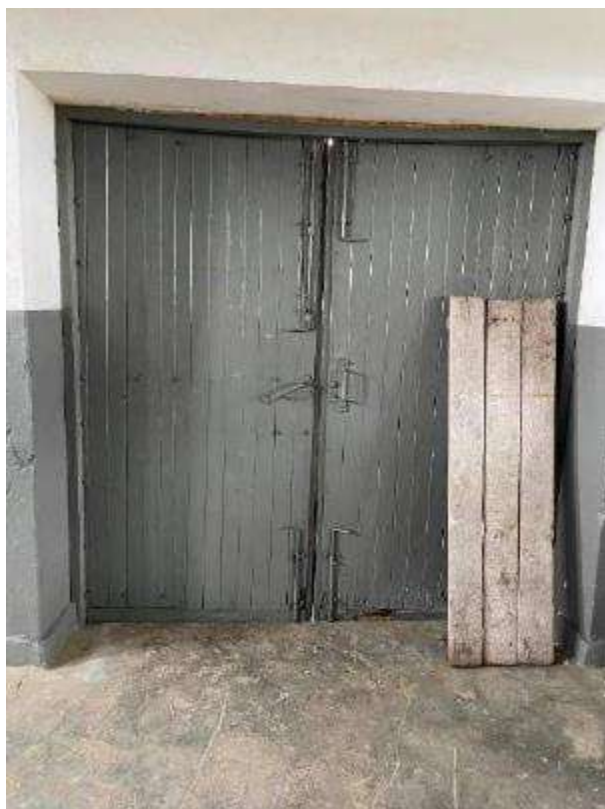
Rysunek 65. Zdjęcie drzwi do wymiany w budynku stacji uzdatniania wody w Przebądowie.
