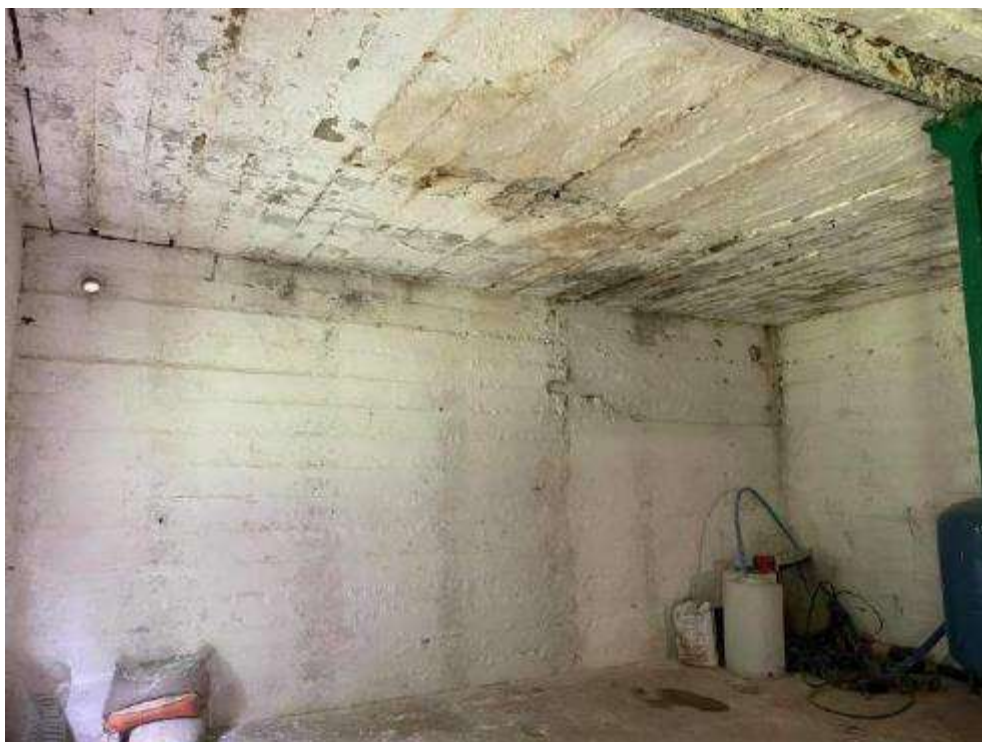
Rysunek 41. Zdjęcie budynku stacji uzdatniania wody w Jachowie wewnątrz (część nieużytkowana).
