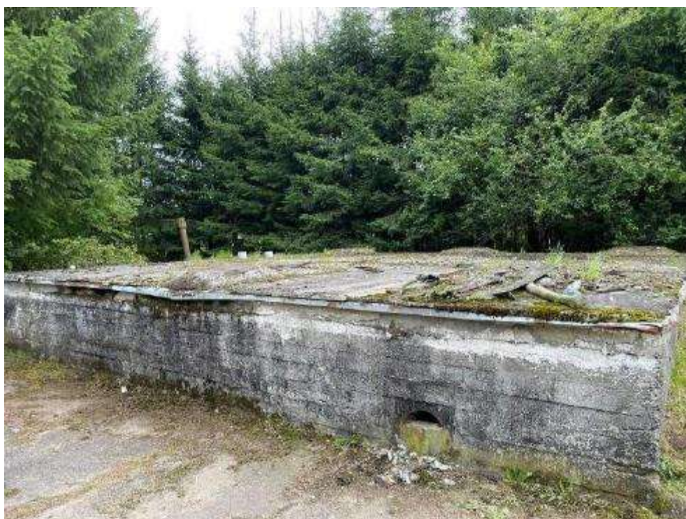
Rysunek 26. Zdjęcie osadników wstępnych na oczyszczalni ścieków w Lełkowie.
