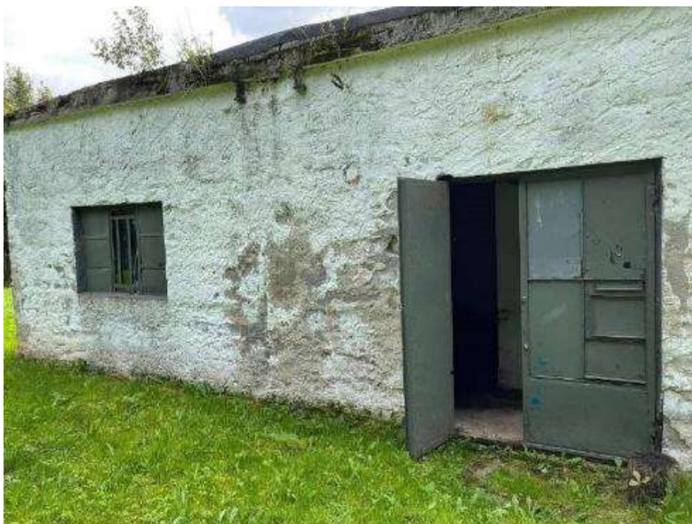
Rysunek 40. Zdjęcie budynku stacji uzdatniania wody w Jachowie.
