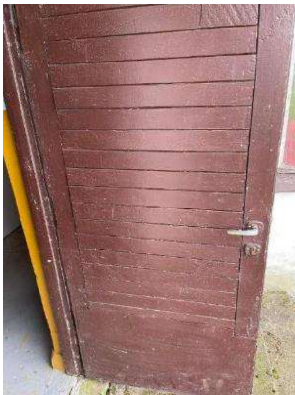
Rysunek 61. Zdjęcie drzwi do wymiany w budynku stacji uzdatniania wody w Przebądowie.
