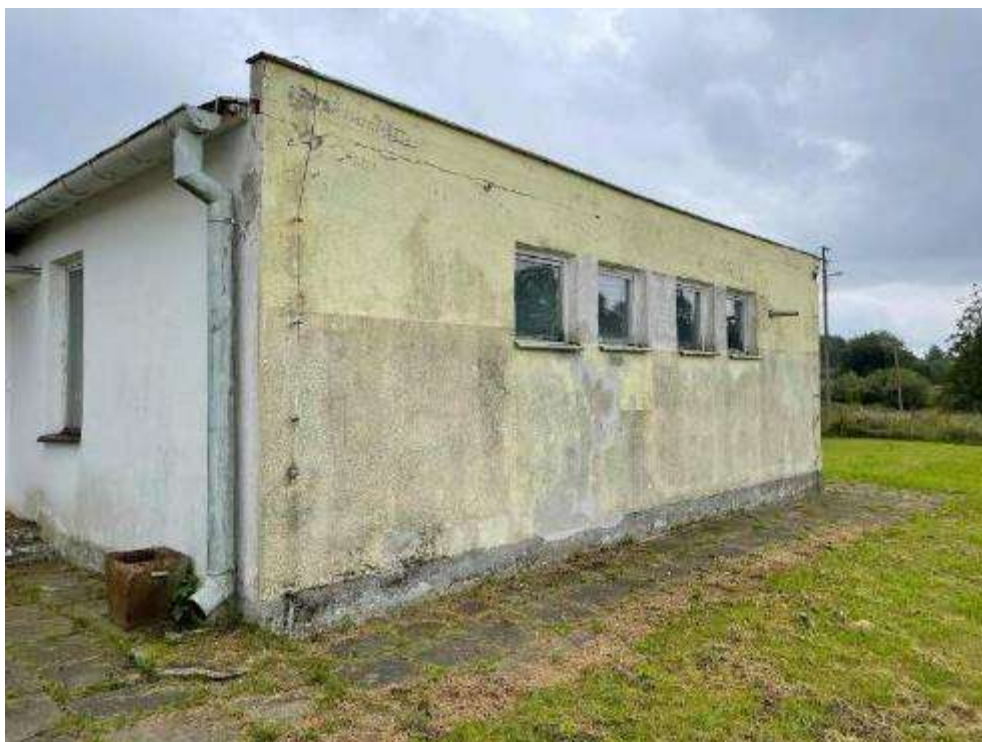
Rysunek 57. Zdjęcie budynku stacji uzdatniania wody w Przebędowie.
