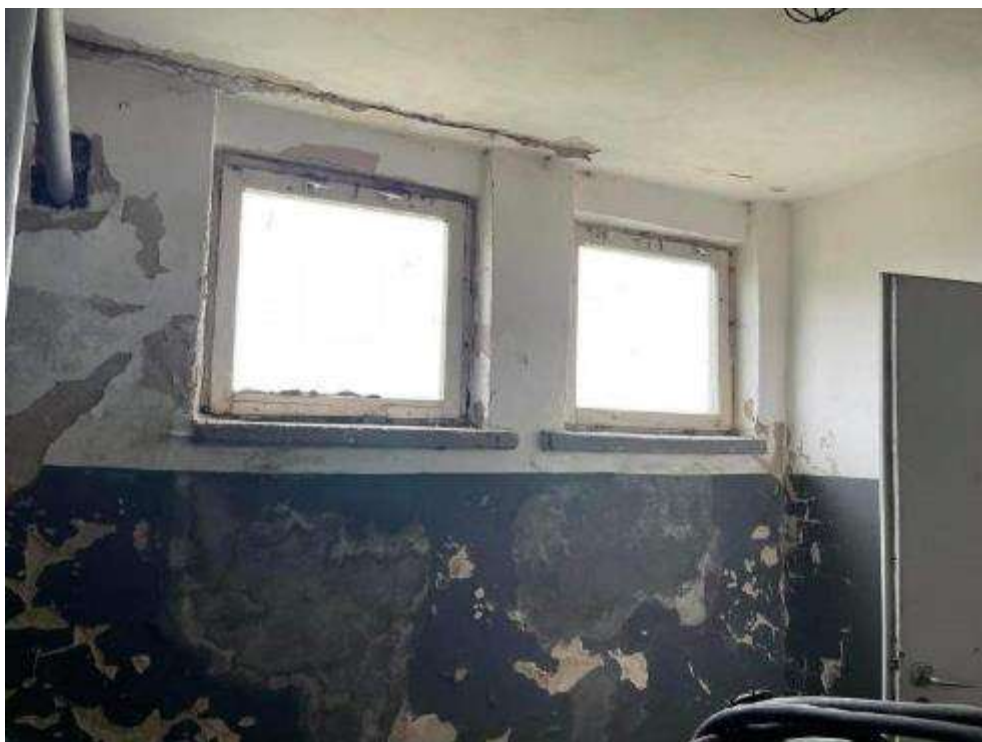
Rysunek 73. Zdjęcie pomieszczeń do remontu wewnątrz w budynku stacji uzdatniania wody w Przebędowie.
