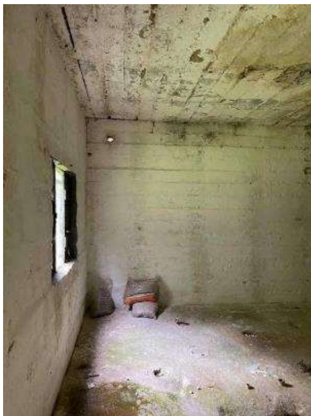
Rysunek 43. Zdjęcie budynku stacji uzdatniania wody w Jachowie wewnątrz (część, nieużytkowana).
