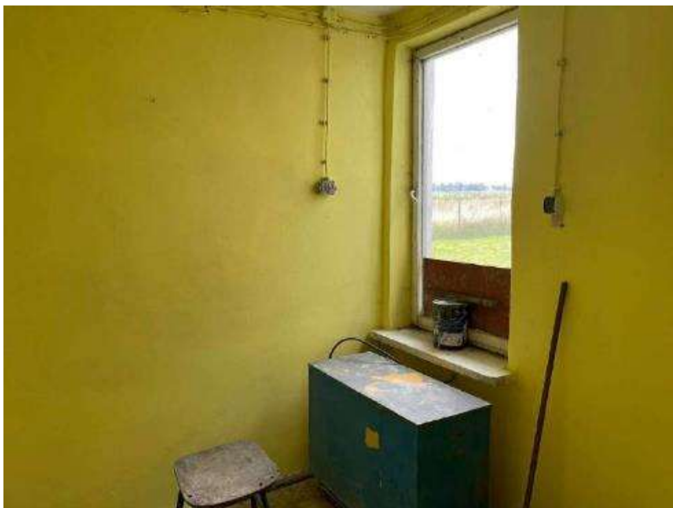
Rysunek 75. Zdjęcie pomieszczeń do remontu wewnątrz w budynku stacji uzdatniania wody w Przebędowie.
