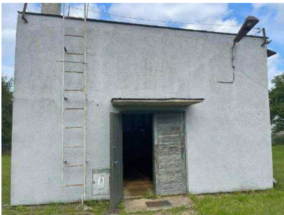
Rysunek 49. Zdjęcie budynku stacji uzdatniania wody w Głębocku.
